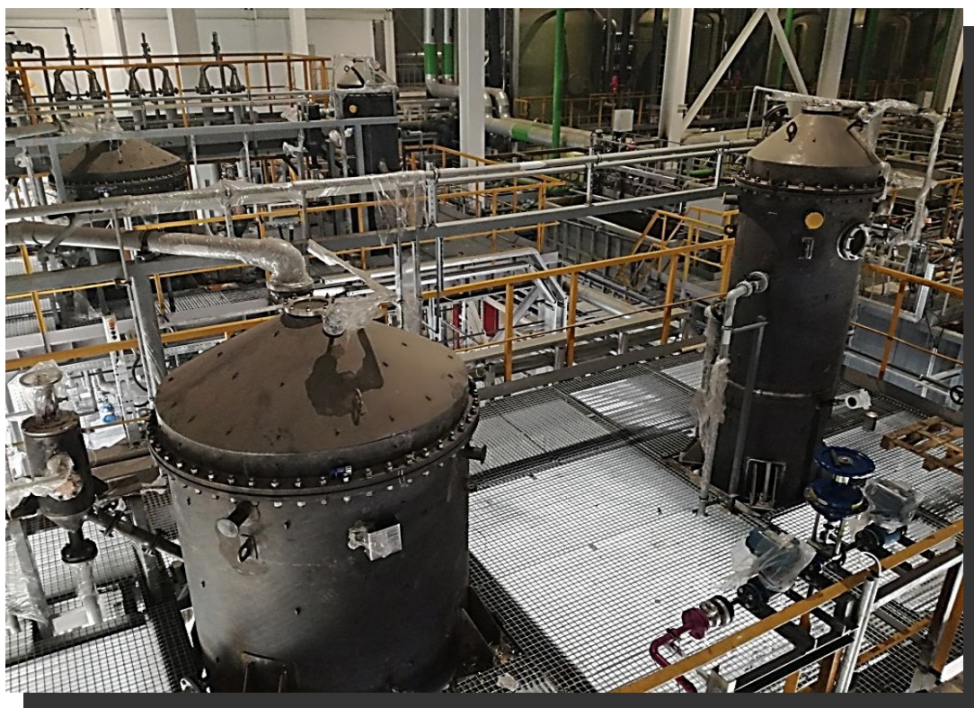
Реакторы умягчения регенерационных стоков
